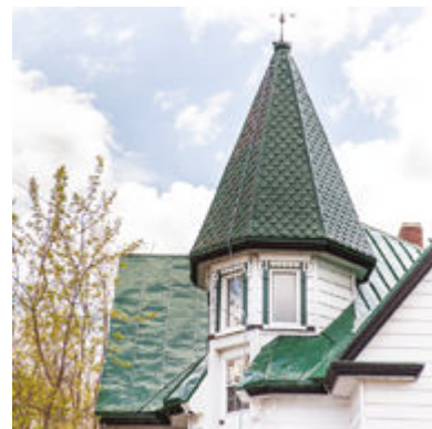
4. Tourelle en demi-hors-œuvre
